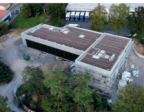
Neubau Feuerwehr Gerätehaus
